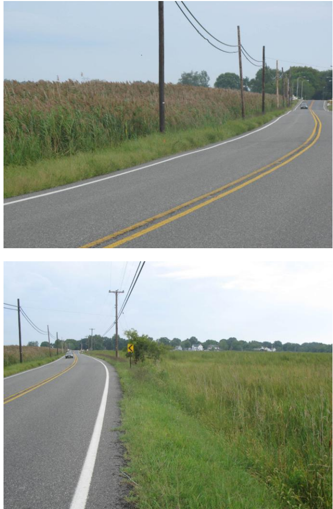
Figure 4. Exemple éloquent du succès du programme de contrôle du roseau commun effectué par le Public Service Enterprise Group au New Jersey. À gauche de la route (photographie du haut), le roseau n'a pas été aspergé d'herbicides. À droite de la route (photographie du bas), un programme complet d'épandage a été effectué (photographies : J. Brisson).
