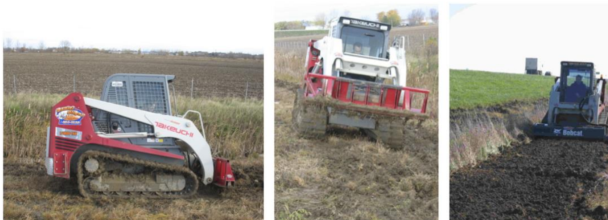
Figure 16 : Préparation du sol à l'aide de la chargeuse compacte sur chenilles «Bobcat» (Site St-Constant; photographie : P. Boivin).
