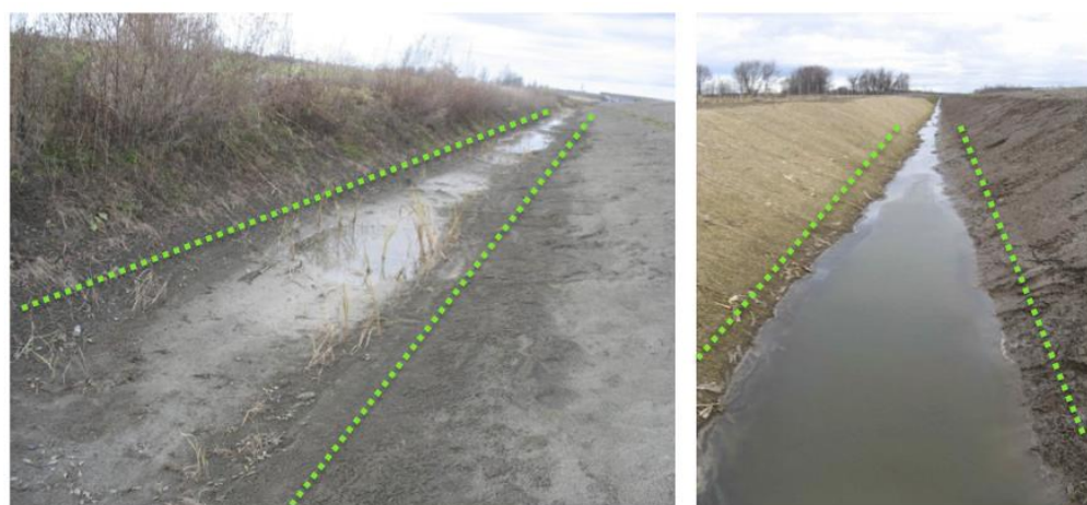
Figure 17 : Éviter l'installation du paillis de plastique en procédant à une plantation avant l'ensemencement du talus et de la berge, même sur pente forte (Site St-Alexandre; photographie : P. Boivin).
