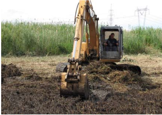
Étape no 2 : mise à nu de la surface du sol et ramassage des débris de fauche (photographie : J. Brisson).
