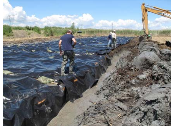
Le résultat final : on installe la toile aussi dans le sol, sur une certaine profondeur, pour empêcher la propagation du roseau commun dans la surface expérimentale par le biais de rhizomes sous la surface du sol (photographie : J. Brisson).
