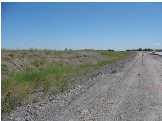
Chantier de l' autoroute 30 , à Saint-Constant. Talus et fossés de drainage fraîchement dénudés : la recette parfaite pour l'implantation du roseau commun dans une région où la plante abonde (photographie : P. Boivin).
